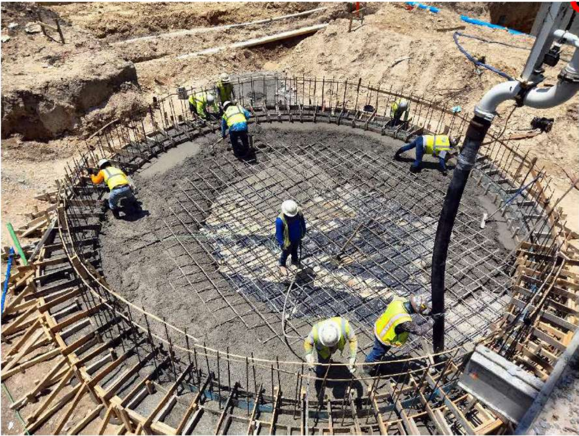
2024.05.20, Clarifier Foundation Concrete Pour
