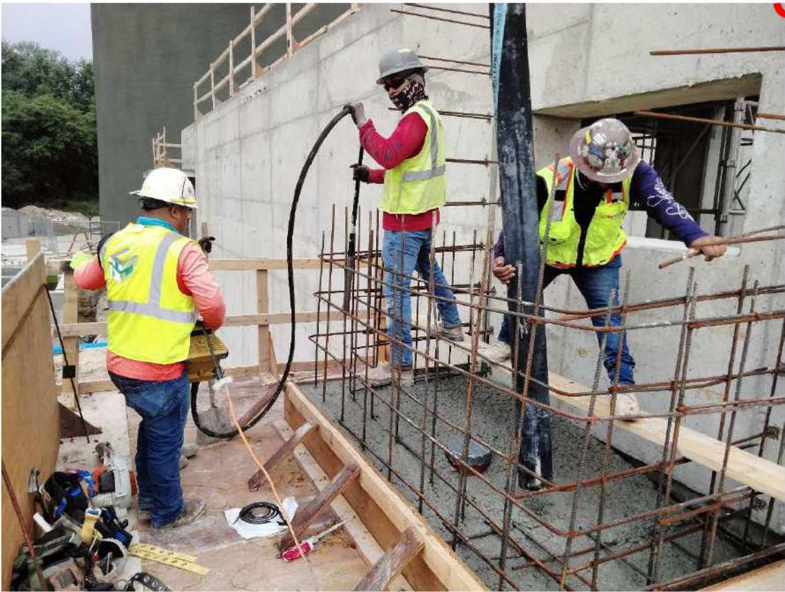
2024.05.08, Aeration Dropbox Slab Concrete Pour
