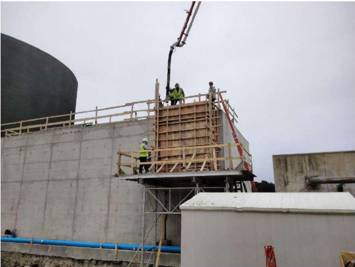
2024.05.13, Aeration Dropbox Walls Concrete Pour
