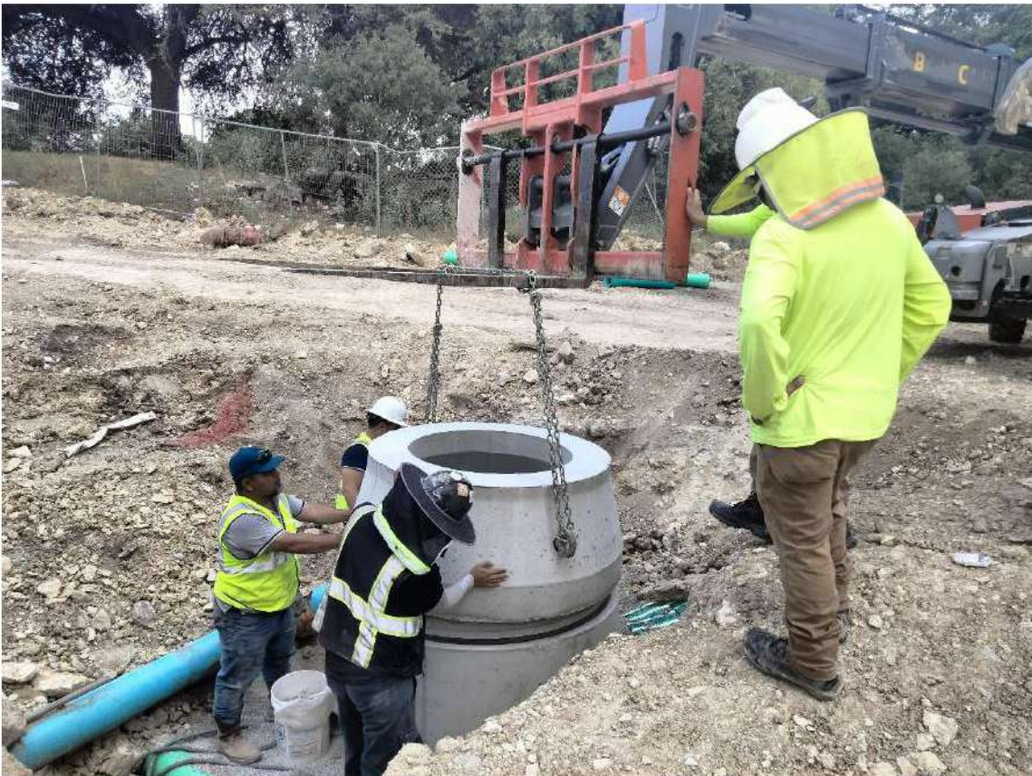
2024.08.30, Setting Manhole A3
