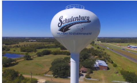
Interstate 10 EST rehabilitation – Schulenburg.
