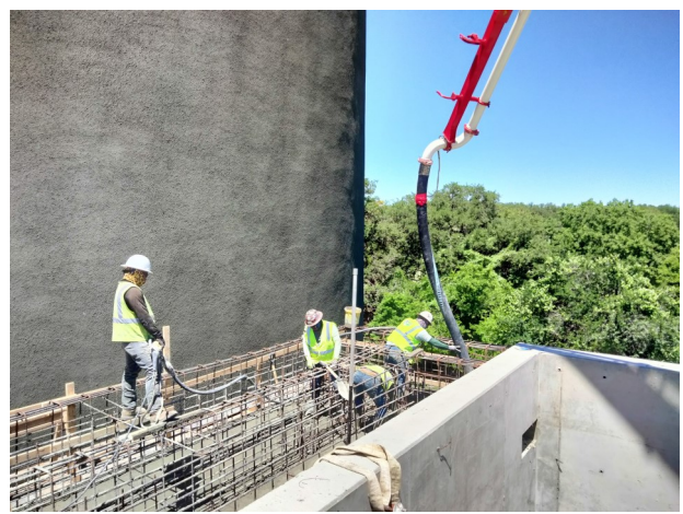
4.11.24, Headworks Slab Pour
