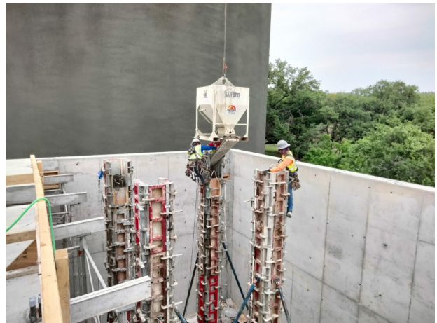
04.01.24, Aeration West Interior Columns Pour
