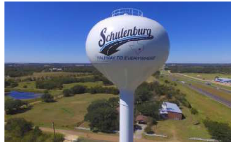
Interstate 10 EST rehabilitation – Schulenburg.
