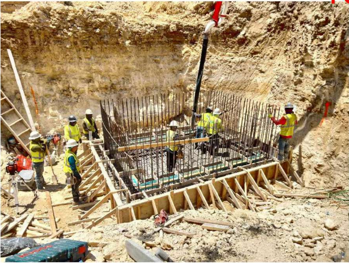
2024.06.07, Wet Well Foundation Concrete Pour
