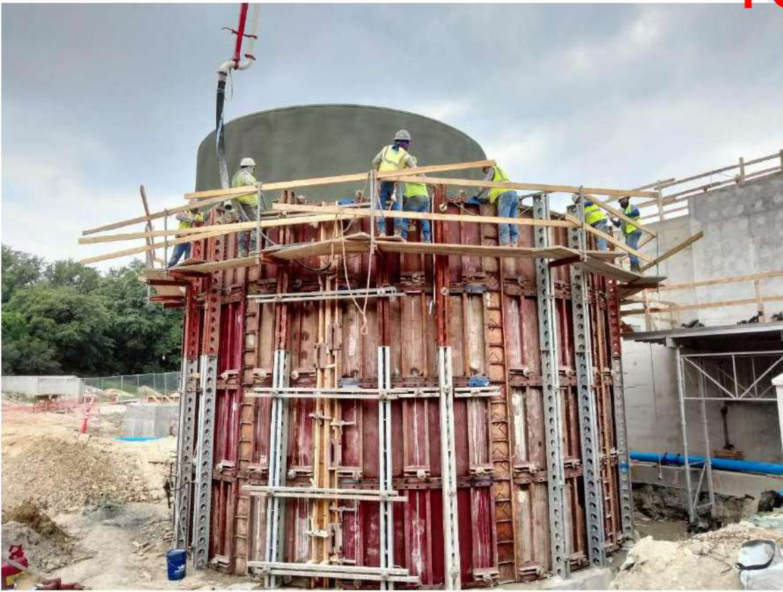
2024.06.03, Clarifier Wall Concrete Pour
