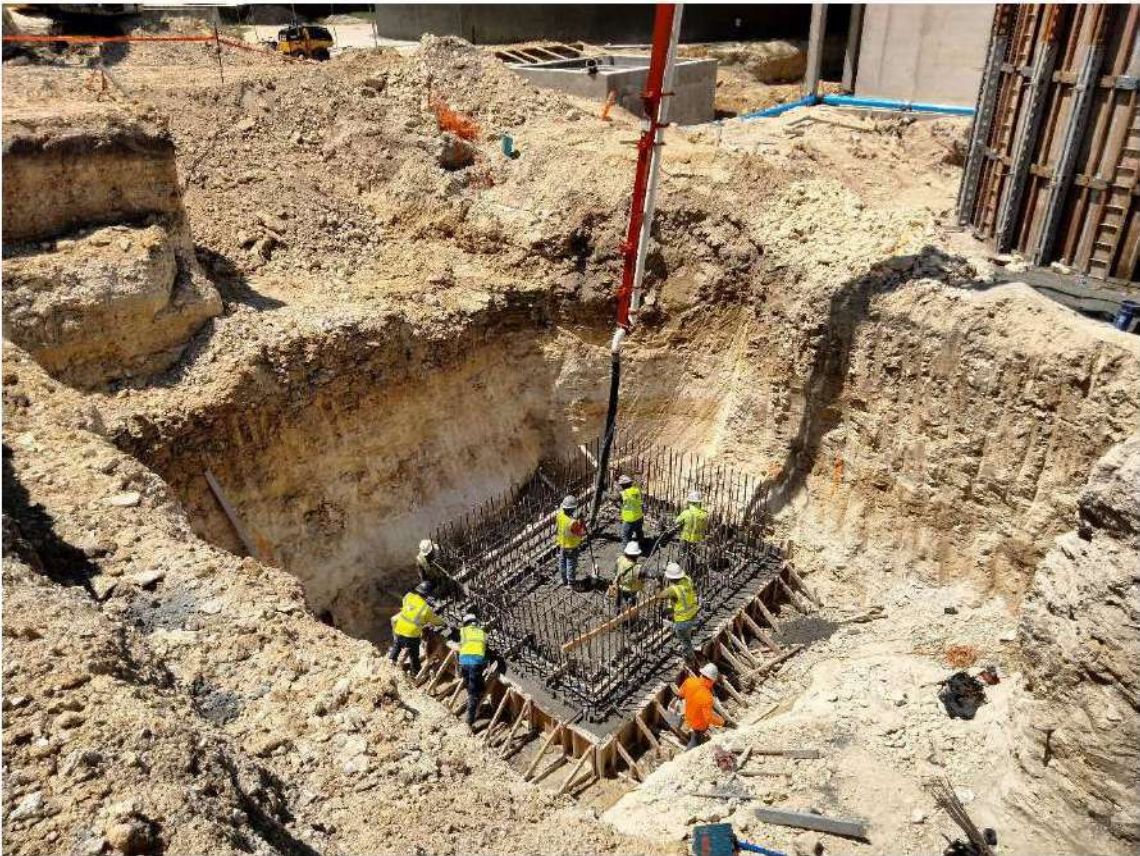
2024.06.07, Wet Well Foundation Concrete Pour
