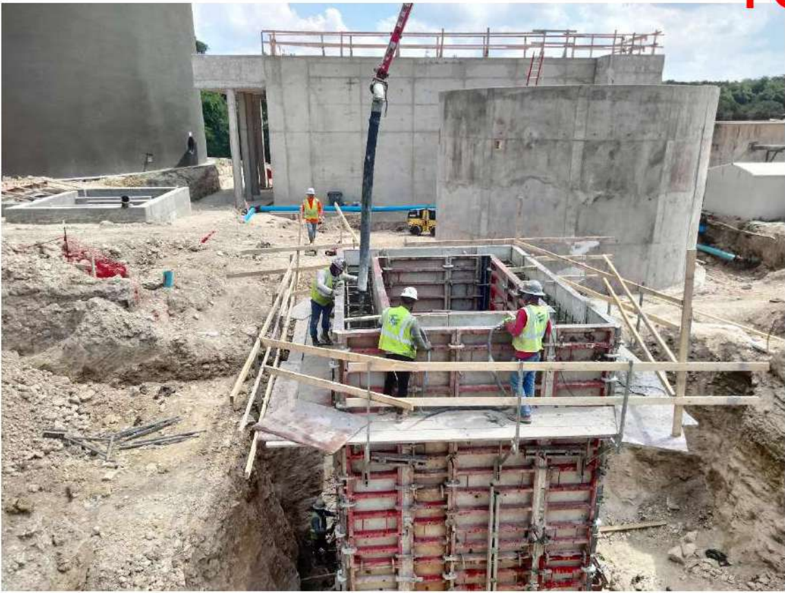
2024.06.17, Wet Well Walls Concrete Pour
