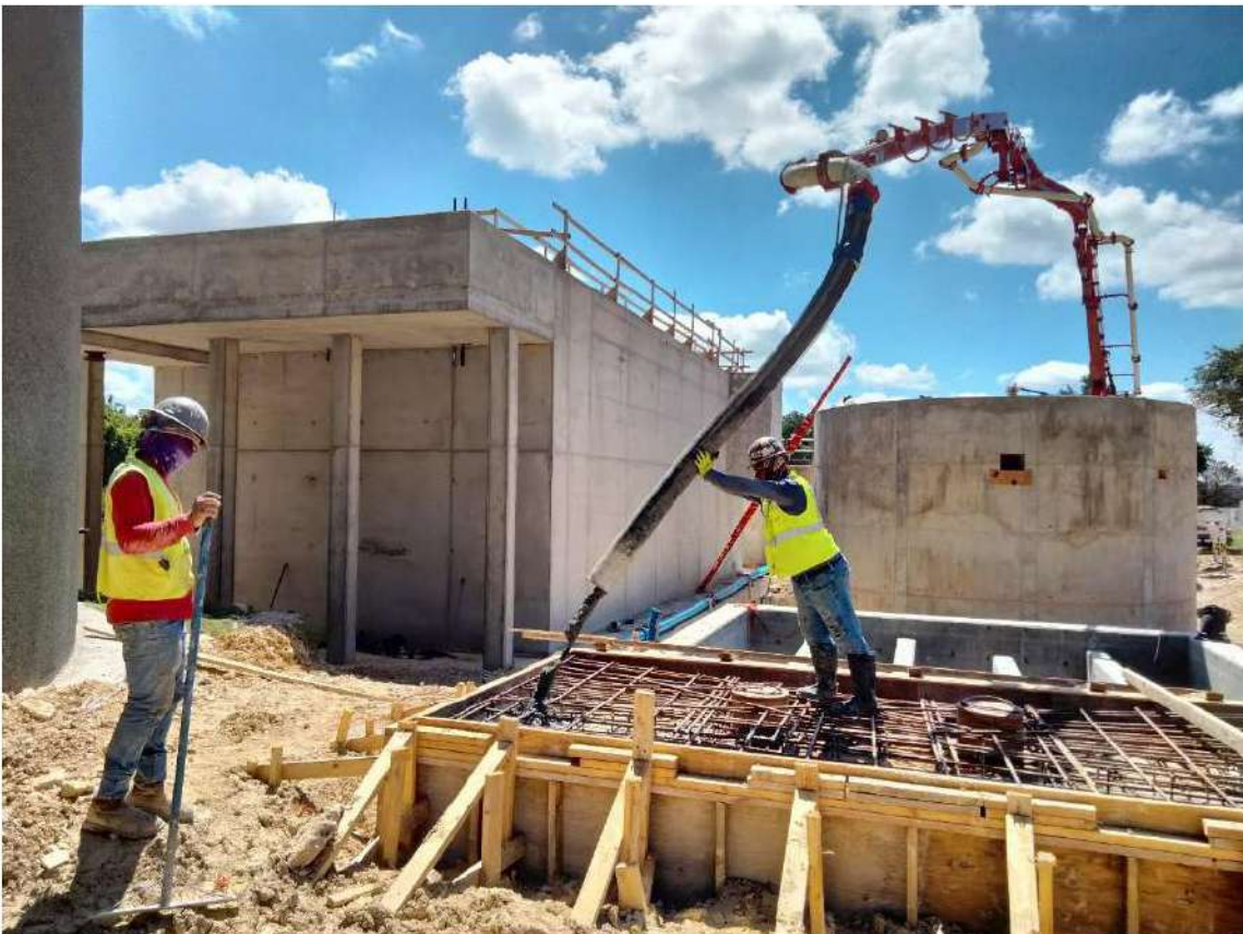
2024.06.24, Effluent Transfer Top Slab Concrete Pour
